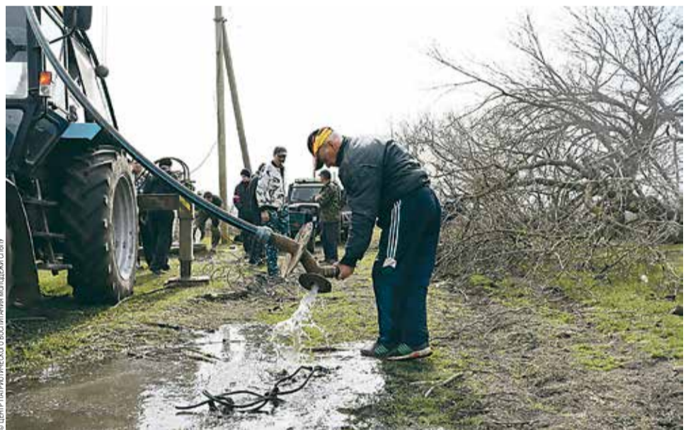
Установка глубинного водяного насоса для обеспечения водоснабжения одного из поселков Запорожской области
